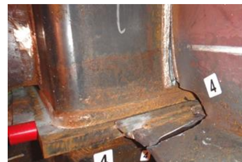
2F, 3Fの側柱接合部で梁下フランジの破断
